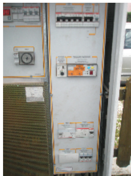
Fig. 30 Particolare quadro elettrico generale I.P. a Folgaria Costa (QCO1)
