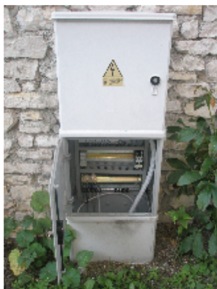
Fig. 11 Quadro elettrico generale I.P. a Folgaria Forrerri (QFO1)
