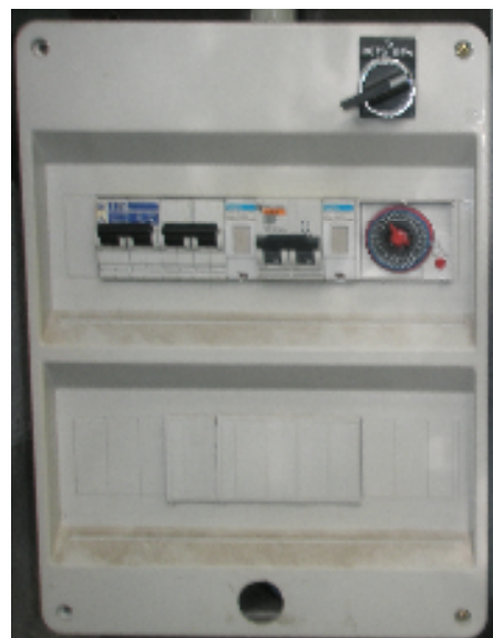
Fig. 28 Particolare quadro elettrico generale I.P. a Folgaria Colpi (QCL1)
