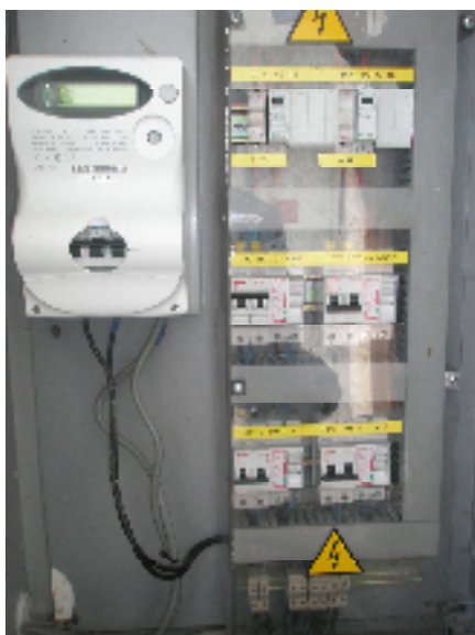
Fig. 17 Quadro elettrico generale I.P. a Folgaria Guardia (QGU1)
