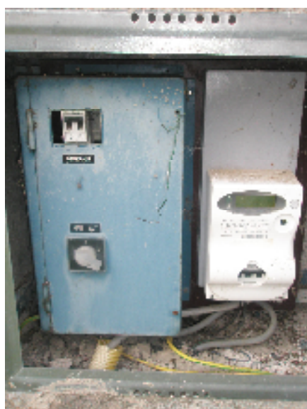
Fig. 31 Quadro elettrico generale I.P. a Folgaria Dazio (QDA1)
