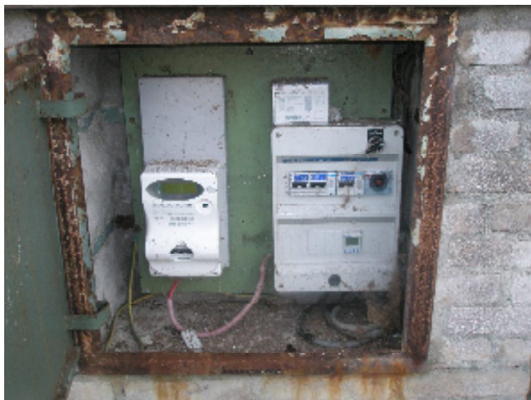
Fig. 25 Quadro elettrico generale I.P. a Folgaria Carpaneda (QCA1)
