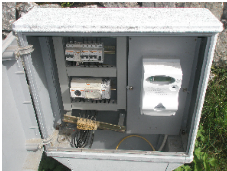
Fig. 15 Quadro elettrico generale I.P. a Folgaria Pneri (QPE1)
