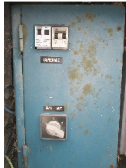
Fig. 24 Particolare quadro elettrico generale I.P. a Folgaria Buse (QBU1)
