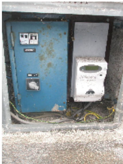
Fig. 23 Quadro elettrico generale I.P. a Folgaria Buse (QBU1)
