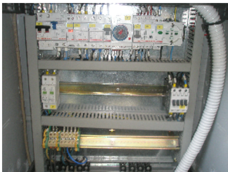
Fig. 12 Particolare quadro elettrico generale I.P. a Folgaria Forrerri (QFO1)
