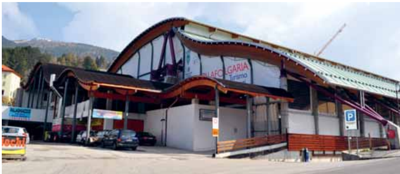
L'area d'ingresso del Palaghiaccio. In primo piano il corpo di cui deve essere completata la copertura. Sulla destra l'ingresso dell'autorimessa, l'anno scorso adeguata alle nuove normative.
