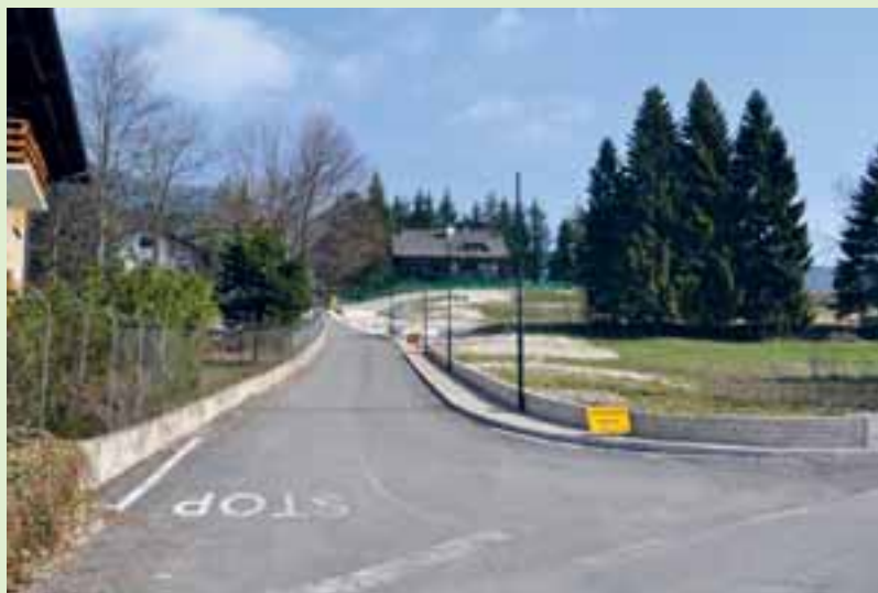
L'incrocio tra via Cadorna e via Oanzi: la strettoia non esiste più, in corso la posa dell'impianto di illuminazione.
