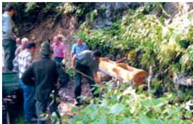
Cacciatori al lavoro per la sistemazione di un "albi" nella zona della frana di Carbonare.
