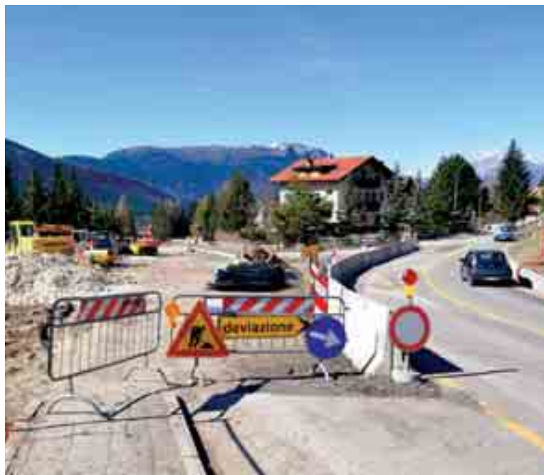
Una panoramica dei lavori in corso lungo la statale.
