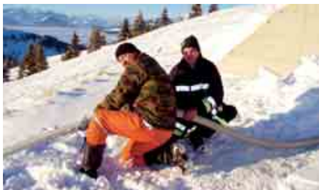
L'operaio comunale Marco Tezzele ed il volontario dei vigili del fuoco Paolo Hueber in una fase dell'intervento al serbatoio Camini
