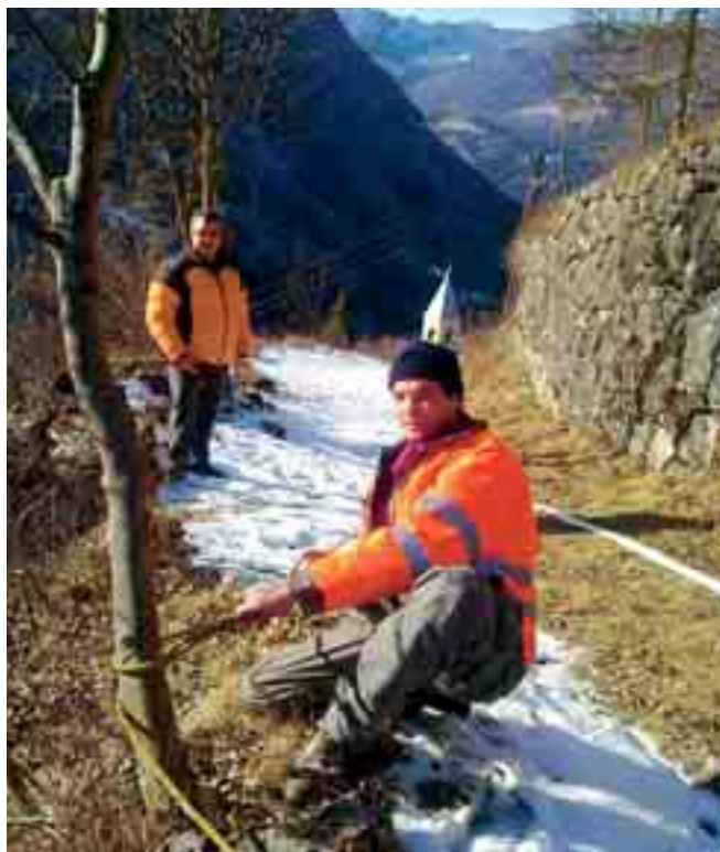
Un momento di preparazione delle tubazioni per riempire la vasca di accumulo.
