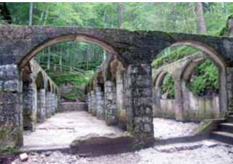
Lavori di recupero del Comando di Virti.
