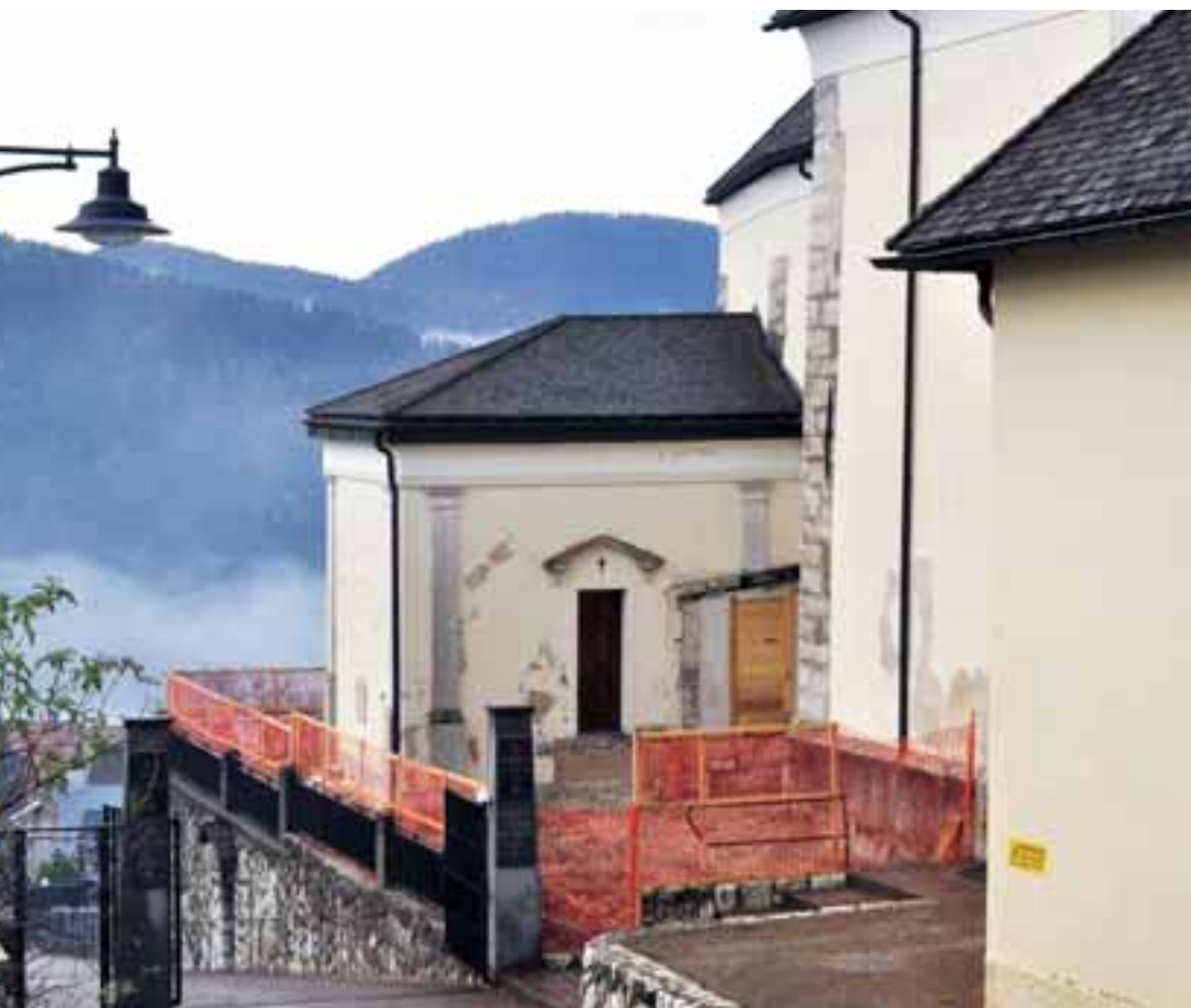
Lavori alla chiesa. Sopra: don Gabriele.
