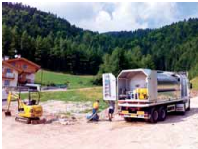
Operazione di rifornimento del serbatoio Cheizel a Costa. Il problema è stato poi superato con una tubatura di supporto.
