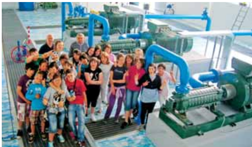
I ragazzi delle scuole medie di Folgaria in visita alla stazione di pompaggio di Terragnolo, iniziativa che la giunta intende replicare per far capire ai più giovani che ogni spreco d'acqua genera costi per la collettività.
