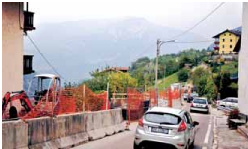
Tempi lunghi oltre misura per il cantiere dell'intervento di Mezzomonte. Evidenti le difficoltà che crea al traffico sulla provinciale Calliano-Folgaria.
