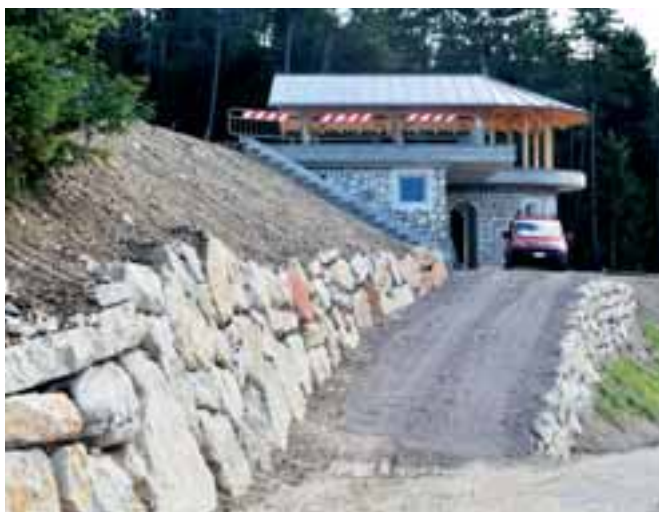
Colta da prospettive diverse l'elegante struttura degli spogliatoi e dei servizi che, affiancata ai campi tennis, ha rimodellato l'intera area.
