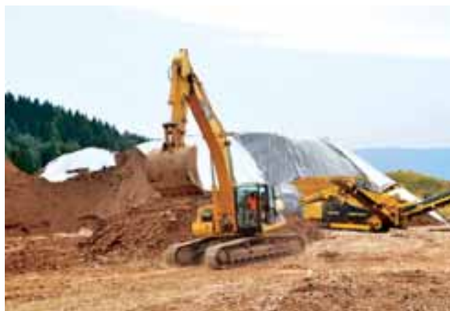
Frantoi ed escavatori preparano i terreni per il raddoppio del campo golf.
