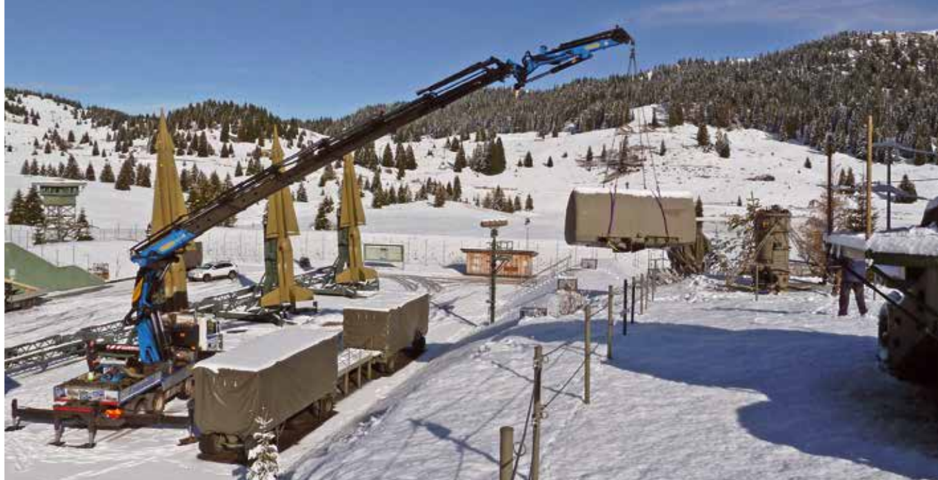
La prima nevicata d'autunno non ha creato particolari difficoltà allo smontaggio della grande antenna del radar "Lopar" che richiede alcuni lavori di restauro e manutenzione. A questi provvederà la cooperativa "Il gabbiano" a Trento.
