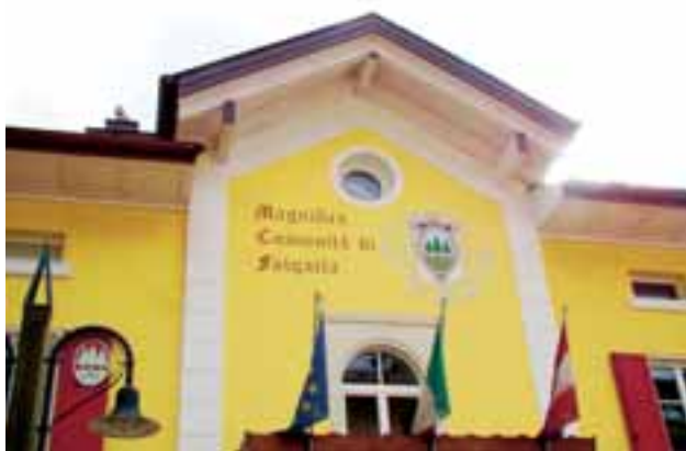
La facciata del Municipio di Folgaria.
