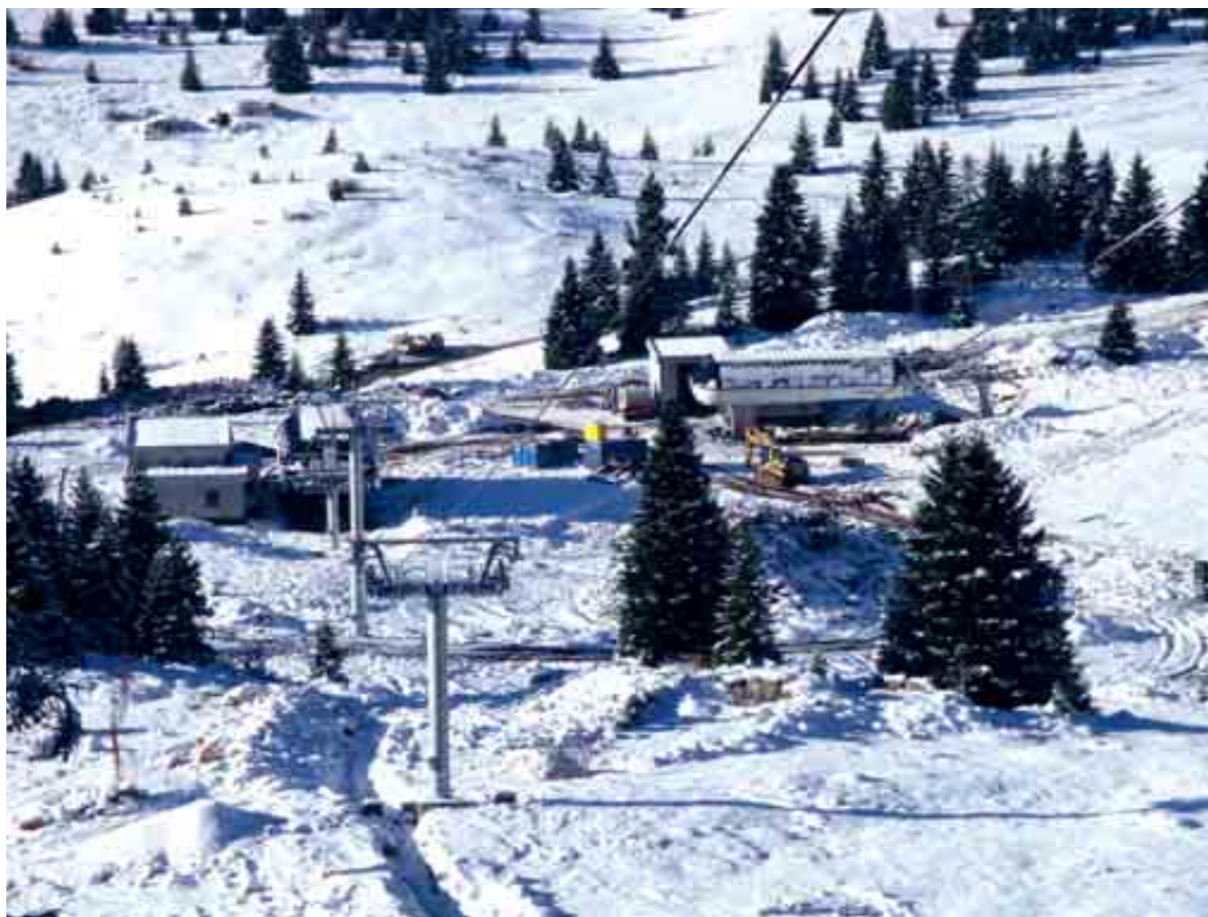
Il cantiere ancora aperto delle due stazioni di partenza, la Termental (a destra) e la Pioverna. La foto risale ai primi giorni di novembre.
