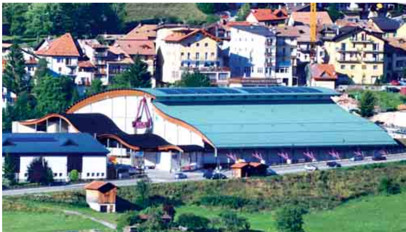
Il Palaghiaccio di Folgaria. A oltre vent'anni dall'inizio della sua costruzione se ne intravede la conclusione, ma ci vorranno ancora almeno due anni di lavori.
