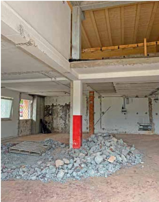
nuova pavimentazione industriale da 15 cm, con sottostante isolamento termico.
