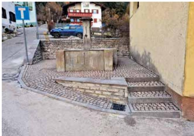
chetti di porfido resinati, formazione di pozzetto per raccolta meteoriche, sistemazione caditoia esistente e tratti di gusce in cls.
