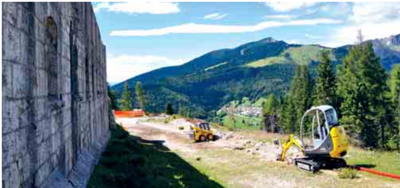
Davanti al bastione del forte più visibile da San Sebastiano si lavora per la posa dei cavi elettrici e dei corpi illuminanti.
