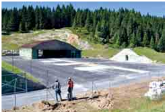
Ripavimentato il grande piazzale dell'hangar di Passo Coe: sono visibili le tre piattaforme in cemento originali sulle quali i missili venivano predisposti al lancio.
