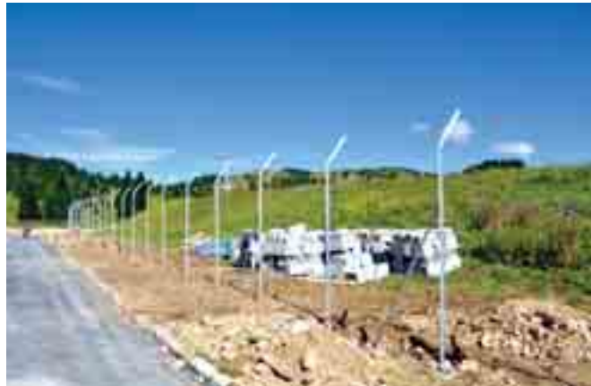
Si sta allestendo la recinzione che circonda tutta l'area dei missili.
